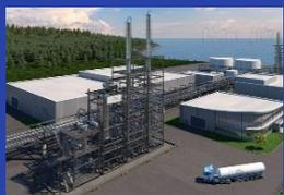
Production du bio méthanol à base d'hydrogène et du CO2 issu de la biomasse. Mise en place d'une unité pilote avec une capacité de production d'environ **70 kt**. Projet n'incluant pas la production d'H2 vert. Projet n'incluant pas la production d'H2 vert
